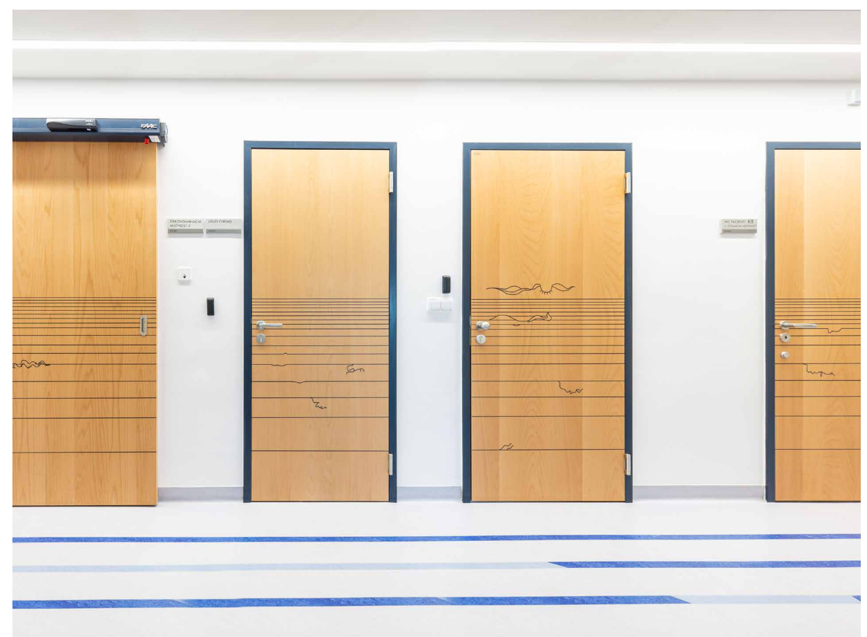
Dveře jsou originálním doplňkem interiéru, ale zároveň splňují řadu striktních požadavků zdravotnického zařízení.
